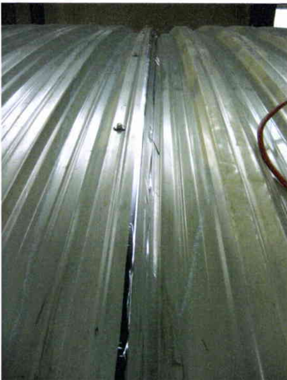
Bild 2: Ein Längsstoß bei den Innenschalen mit aluminiumbedampften Klebeband überklebt
