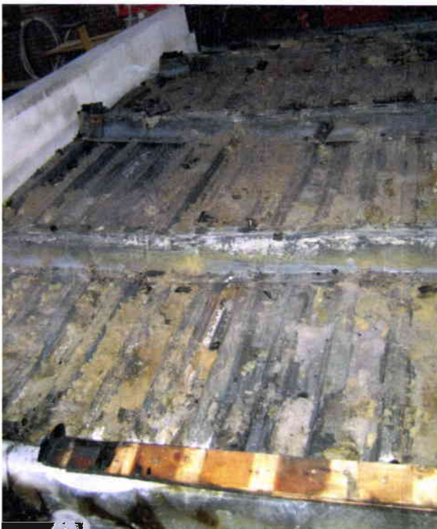
Bild 16: Ansicht des Probekörpers in Spannrichtung nach Abnahme der Außenschale und der Beseitigung der Steinwolle
