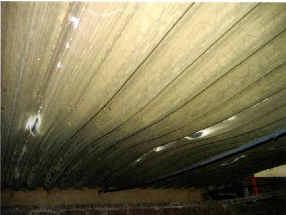
Bild 18: Die Unterseite des Probekörpers nach Versuche
